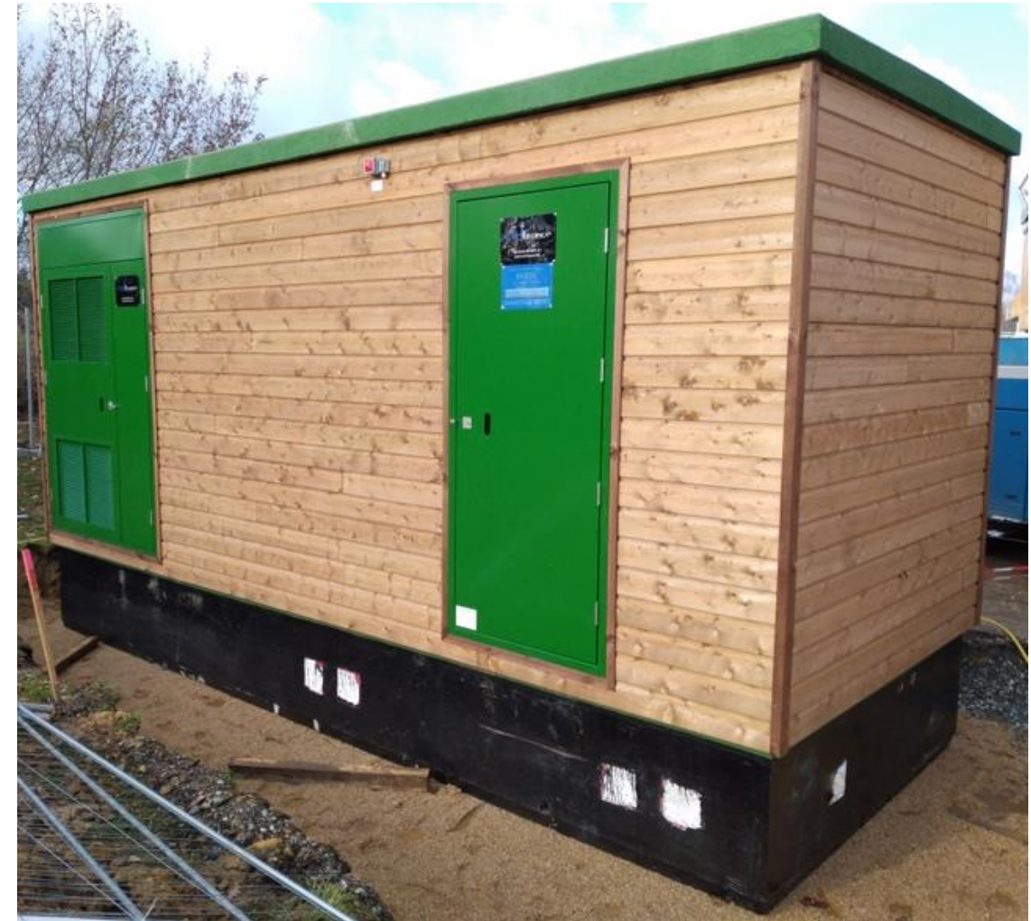
Illustration 17 : Exemple de poste de livraison – Centrale photovoltaïque de Saint-Jory de Chalais en Dordogne (Source : EREA Ingénierie )
